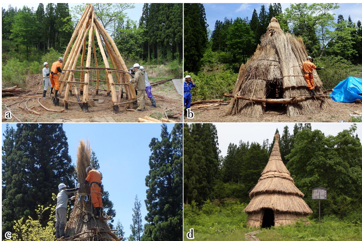
図 2. 山小屋再建設の工程. 骨組み (a). 萱葺き (b). 頂点の仕上げ (c). 完成した山小屋 (d). a は小林誠博士, b, c は村山暁氏, d は著者 (富塚) 撮影.
