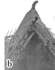
図 1. 松之山で利用されていた山小屋. 通常の入入口 (a) に張り出し構造がつけられることもあった (b). 写真は小口成一氏撮影. 撮影日, 撮影場所は不明.
