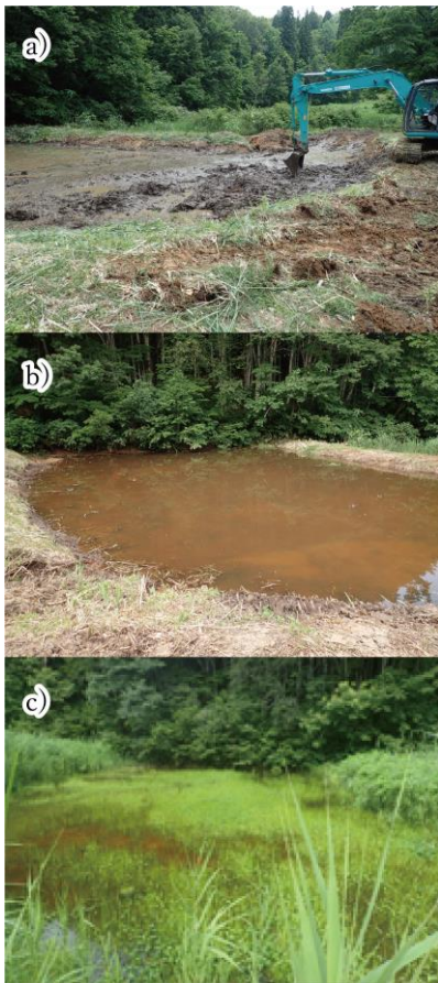
図2. 大谷地の池Cにおけるバックホウによる池底の泥と植物体の除去作業の風景 (a). b は除去作業直後 (2018/6/14), c は作業 2 ヶ月半後 (2018/8/29) の状況.
