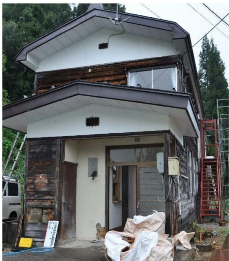
【改修工事が進む藤倉ハウス】
